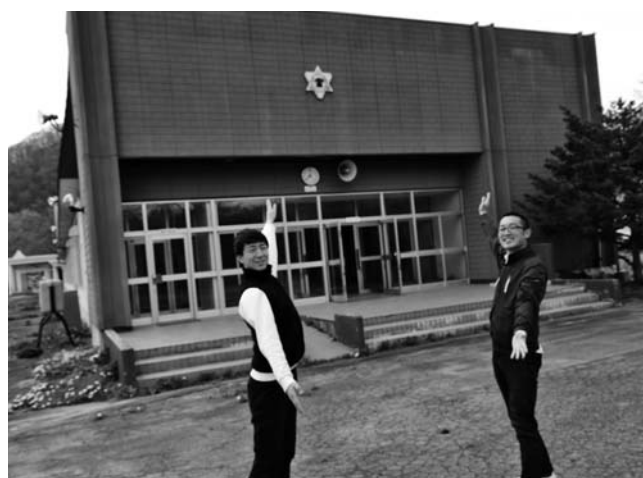
サテライトオフィス、コワーキングスペース実証事業を実施する旧常室小学校
